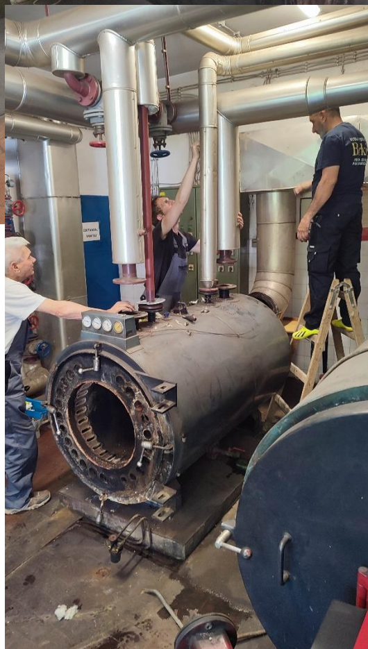
Demontaža starog kotla
