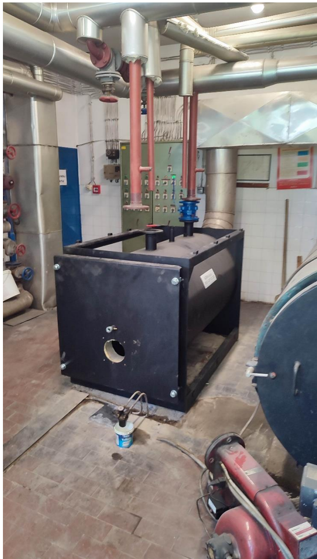
Ugradnja novog kotla
